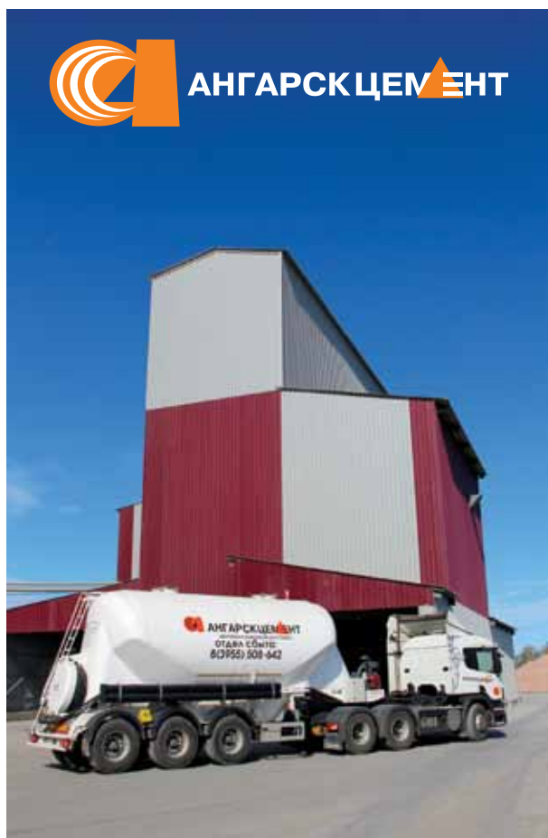
Модернизированная станция по отгрузке навалочного цемента в автотранспорт и новые цементовозы марки Scania.
